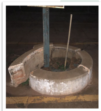
ANTES DA REFORMA!
